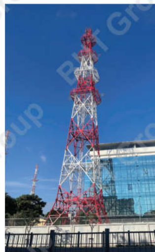
Trụ tự đứng tam giác Triangular self-supporting tower
