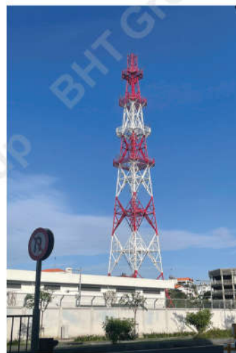
Trụ tự đứng tam giác Triangular self-supporting tower
