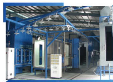
Sơn tĩnh điện Automatic powder coating
